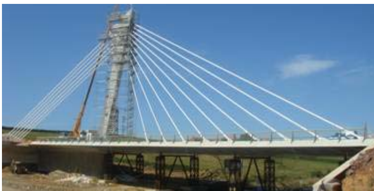
Fig. 10 Enfilado, izado y tesado de los tirantes
