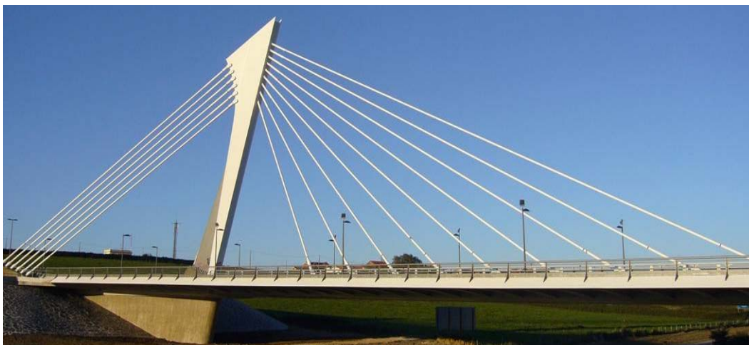
Fig. 6 Vista general de la estructura y del estribo apuntado en E2.
