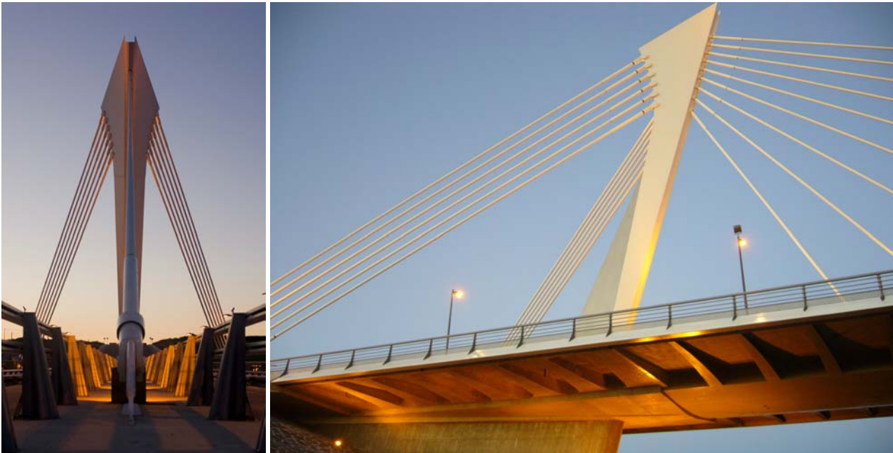
Fig. 4 Mástil metálico inclinado
