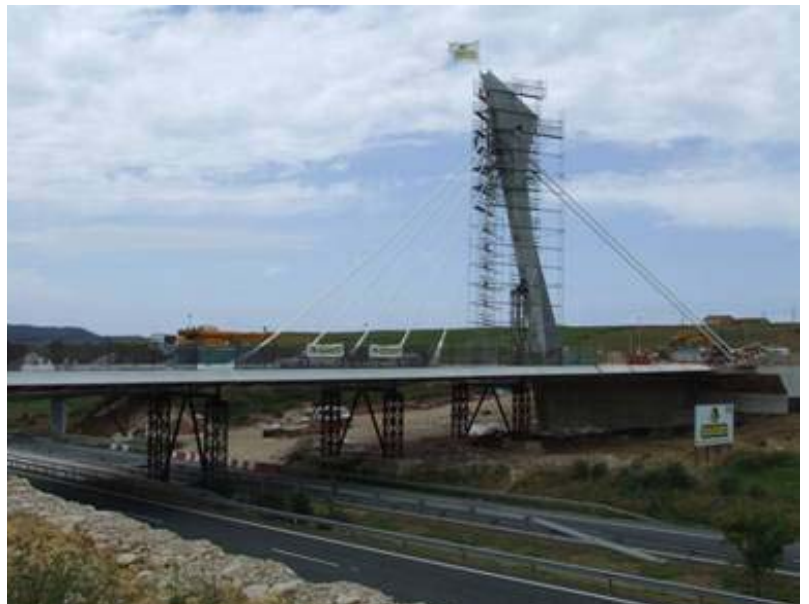
Fig. 10 Enfilado, izado y tesado de los tirantes
