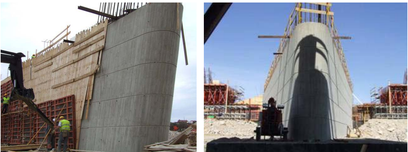
Fig. 7 Imágenes de la construcción del frente apuntado del estribo E2
