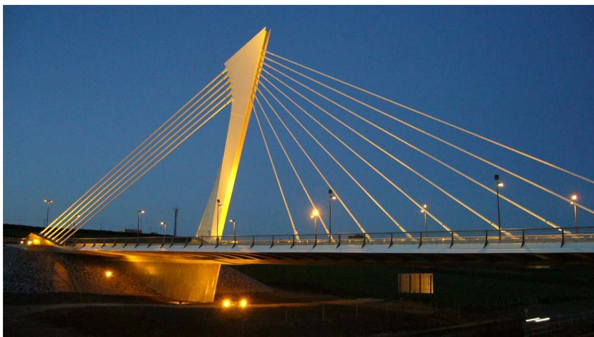
Fig. 14 Vista nocturna del puente acabado
