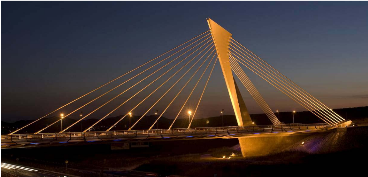
Fig. 2 Vista nocturna del puente construido
