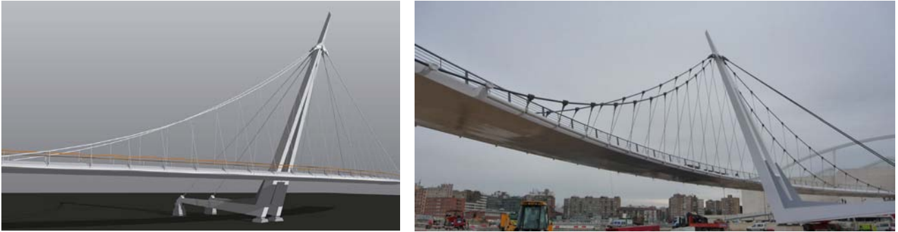
Fig. 10 Infografía de proyecto del vano principal junto a una imagen de la estructura construida
