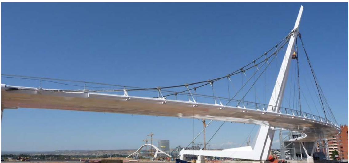
Fig. 11 Vista del vano principal colgante de 90 m al final de la construcción
