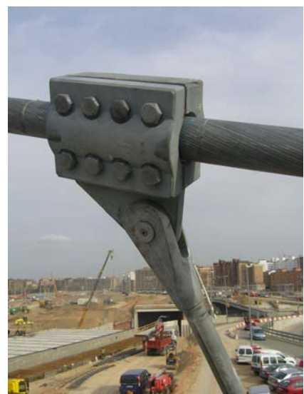
Fig. 15 Imágenes del izado de los tramos de tablero metálico, e instalación de anclajes de péndolas a cables principales
