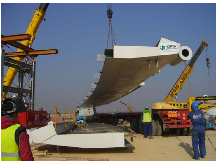
Fig. 15 Imágenes del izado de los tramos de tablero metálico, e instalación de anclajes de péndolas a cables principales
