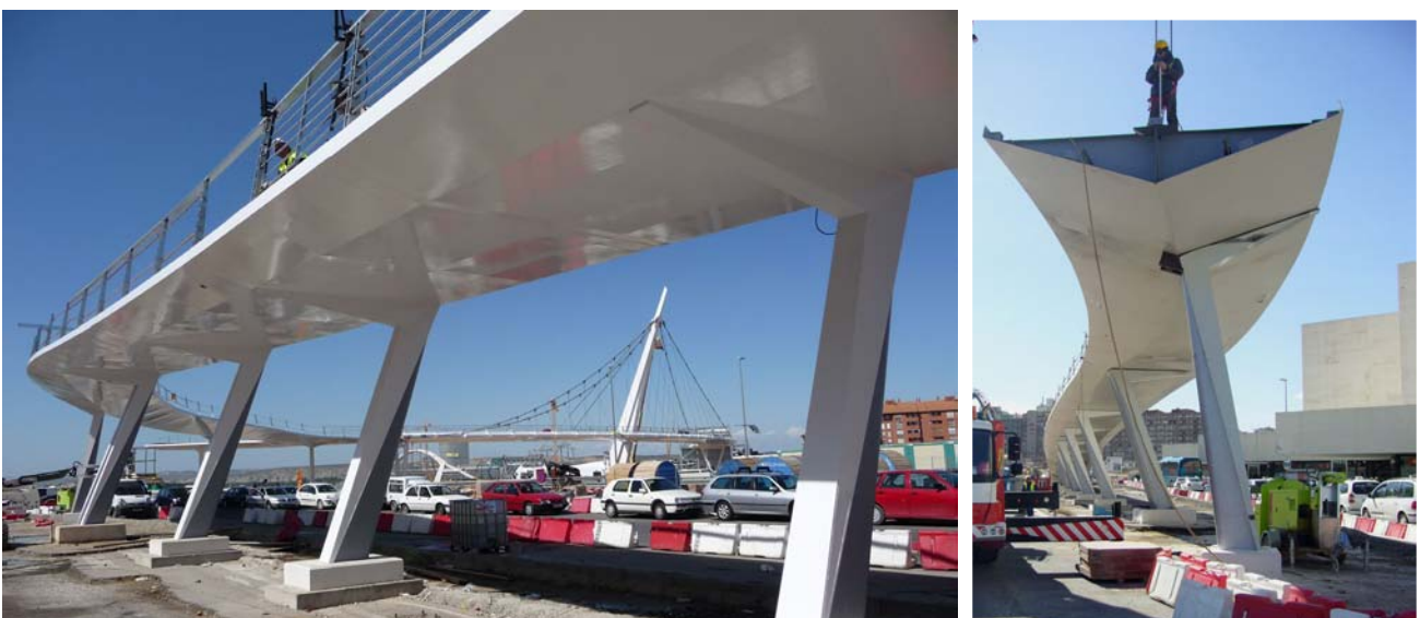
Fig. 13 Imágenes de la estructura de rampa de acceso mixta y los pilares metálicos inclinados
