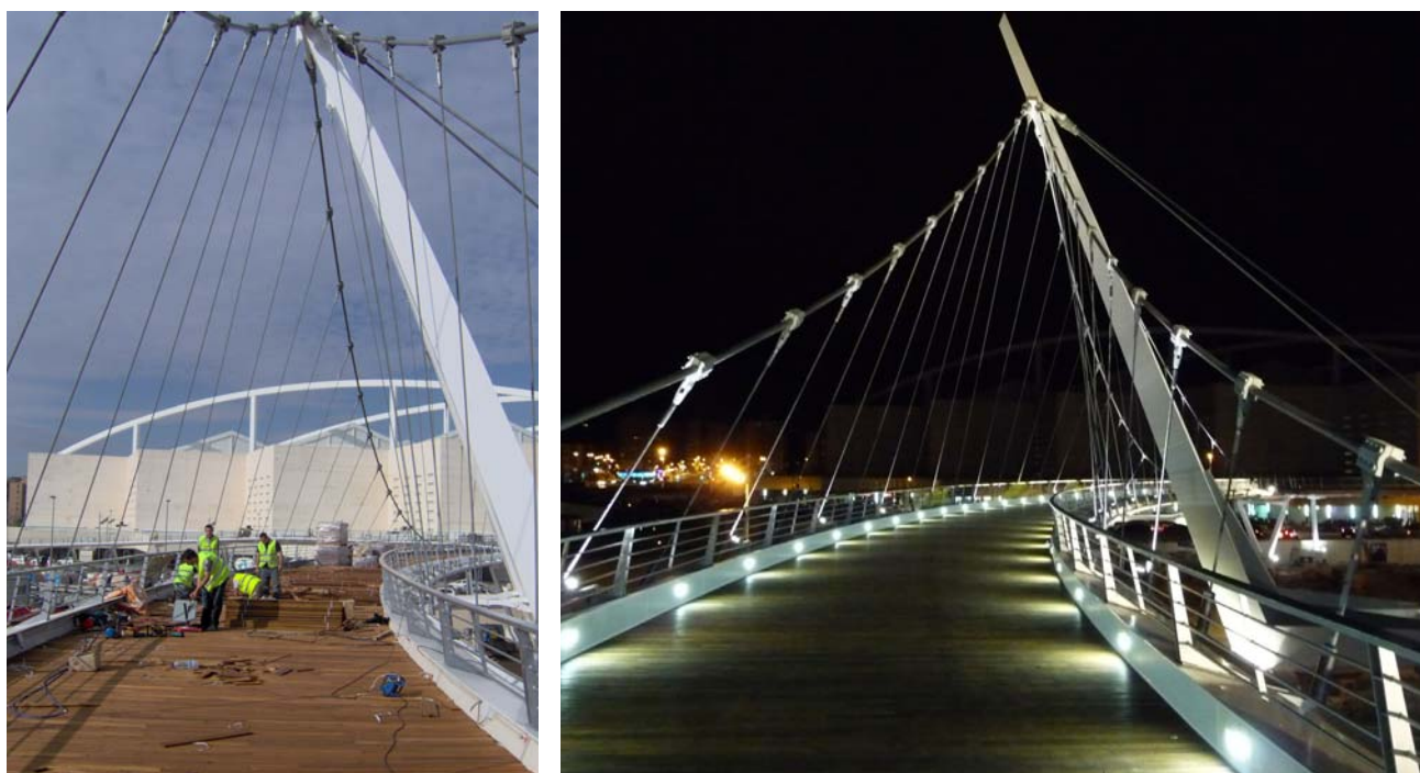
Fig. 16 Imagen del montaje del pavimento de madera de elondo, y vista nocturna interior de la pasarela acabada
